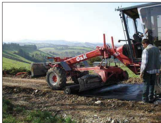
Pose du géotextile
