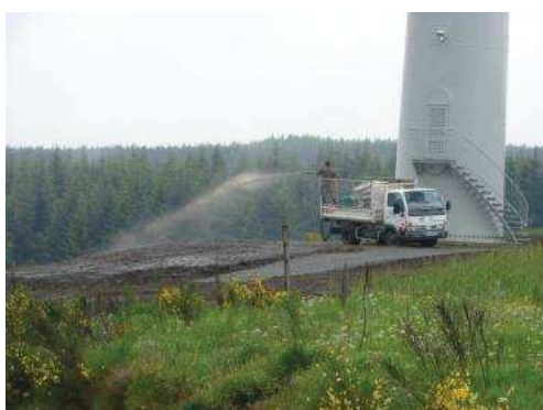
Revégétalisation par d'hydroseeding
