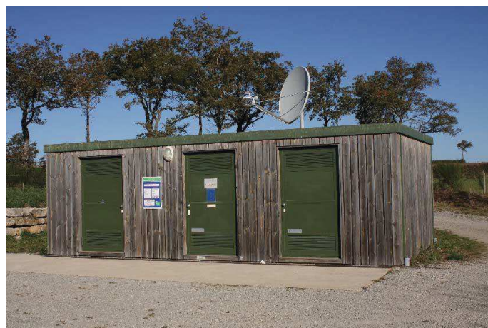
Figure 23: Exemple de bardage bois et peinture vert foncé (Source: ABIES)
