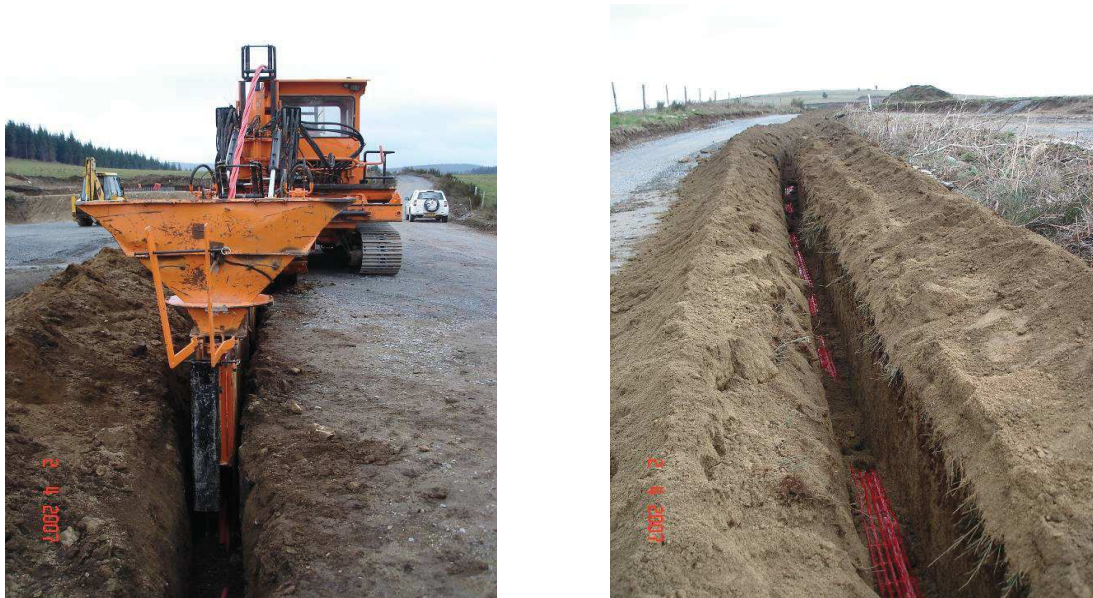
Réalisation de la tranchée et de la pose du câble simultanément
